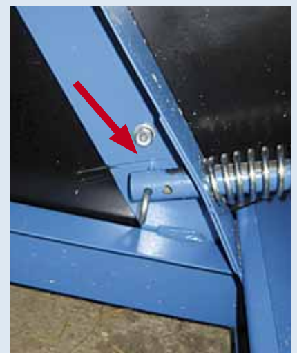
Dieser Federsplint löste sich bei der Unfallmaschine – Verbogener Rahmen (trotz Materialverstärkung) wegen fehlender Dämpfung des Anschlages
