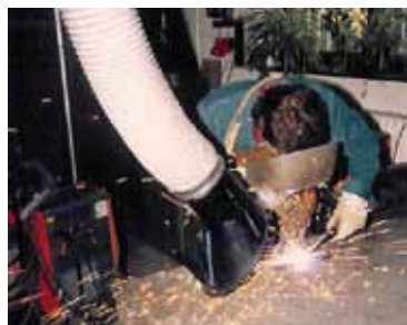
Absaugung bei Schweißarbeiten
